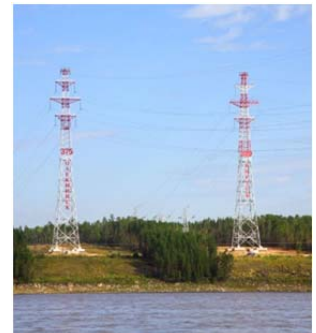
Строительство ЛЭП. Якутия, настоящее время
