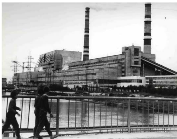
Здание Приморской ГРЭС. 1984 г.
