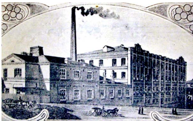
Электрическая станция т/д «Кунст и Альберс». Владивосток, 1911 г.
