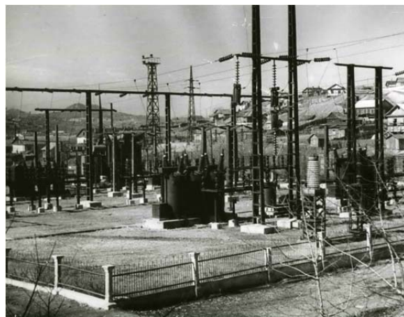
Распределительная электроподстанция, Владивосток. 1958 г.
