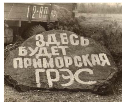
Памятная глыба, заложённая на месте строительства будущей Приморской ГРЭС. 1960 г.
